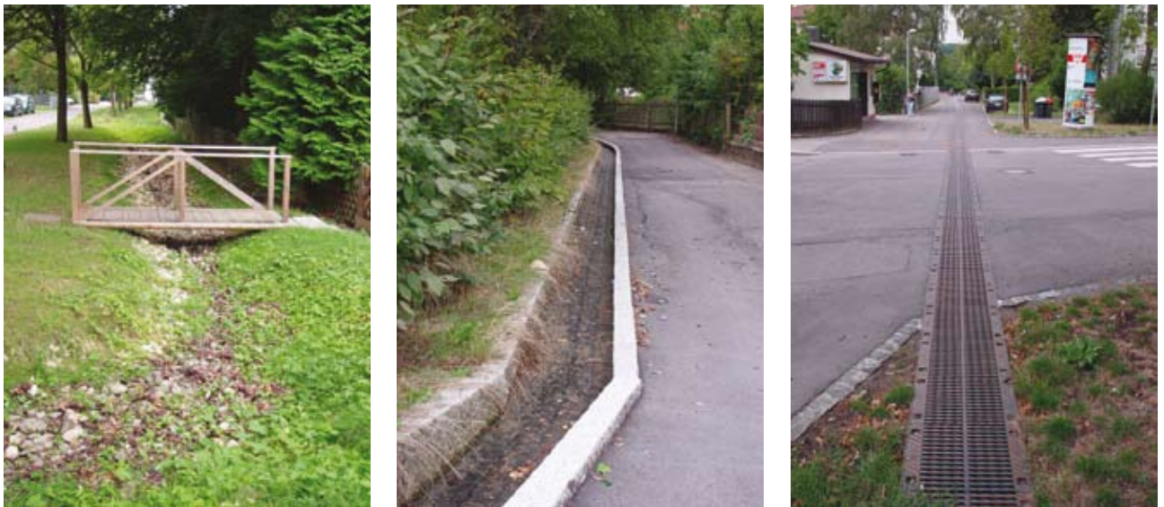
Abb. 29: Verschiedene Formen der oberirdischen Ableitung
