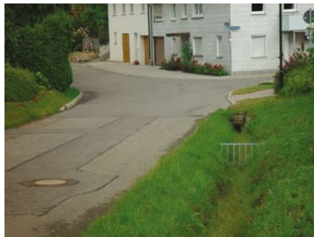
Abb. 22: Einleitung einer Aussengebietsdrainage aus einem Wegeseitengraben in das Kanalisationsnetz
