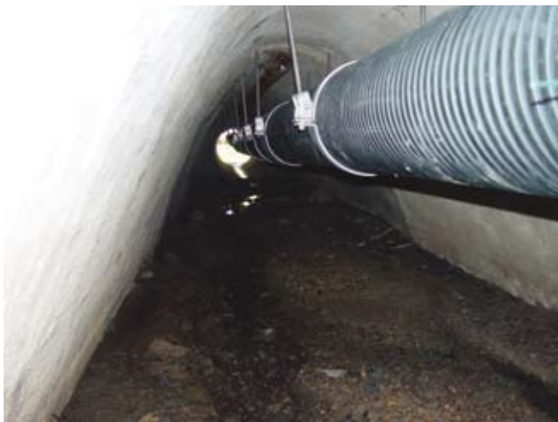
Abb. 30: Rohr-in-Rohr-Lösung zur Ableitung von Fremdwasser (links abgehängte Fremdwasserleitung in Göppingen, rechts Sohlleitung zur Ableitung eines Baches im Mischwassersammler in Freiberg/Sachsen (Bild: Kovacic Ingenieure GmbH, Sigmaringen))
