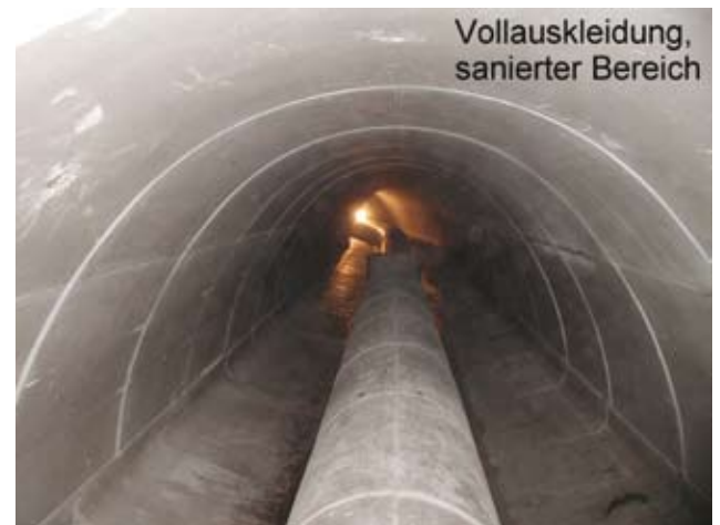
Abb. 30: Rohr-in-Rohr-Lösung zur Ableitung von Fremdwasser (links abgehängte Fremdwasserleitung in Göppingen, rechts Sohlleitung zur Ableitung eines Baches im Mischwassersammler in Freiberg/Sachsen (Bild: Kovacic Ingenieure GmbH, Sigmaringen))
