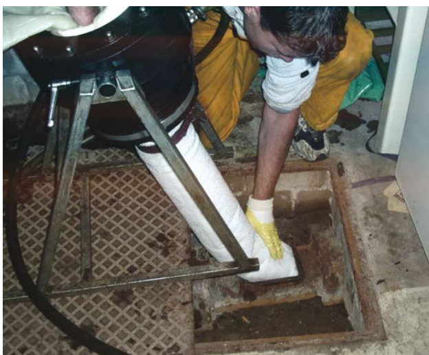
Abb. 70: Schlauchlinersanierung über einen Revisionschacht innerhalb eines Hauses: Inversion des Inliners (links), Freischneiden des Liners (rechts)
