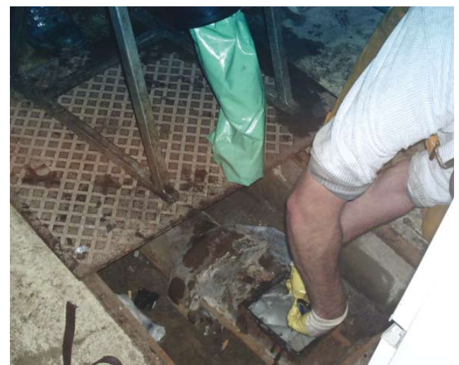
Abb. 70: Schlauchlinersanierung über einen Revisionschacht innerhalb eines Hauses: Inversion des Inliners (links), Freischneiden des Liners (rechts)
