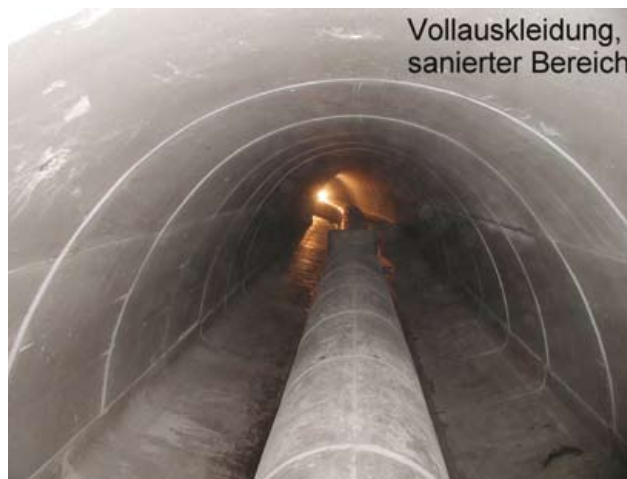
Abb. 82: Rohr-in-Rohr-Lösung zur Ableitung von Fremdwasser (links abgehängte Fremdwasserleitung in Göppingen, rechts Sohlleitung zur Ableitung eines Baches im Mischwassersammler in Freiberg/Sachsen (Bild: Kovacic Ingenieure GmbH, Sigmaringen)
