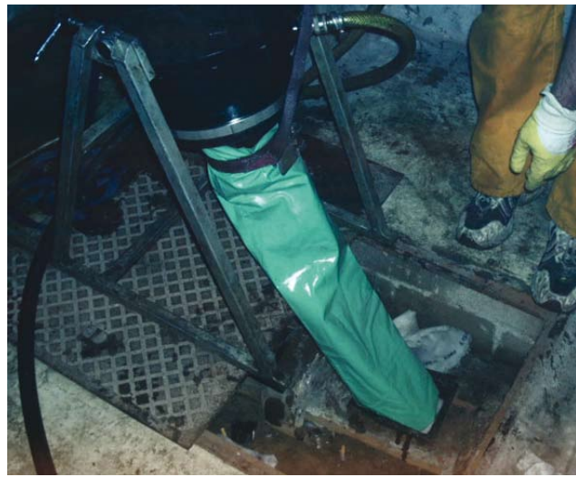
Abb. 71: Schlauchlinersanierung über einen Revisionschacht innerhalb eines Hauses: Einbringen des Stützschlauches (links), Stützschlauch an Inversionskanne angeschlossen (rechts)
