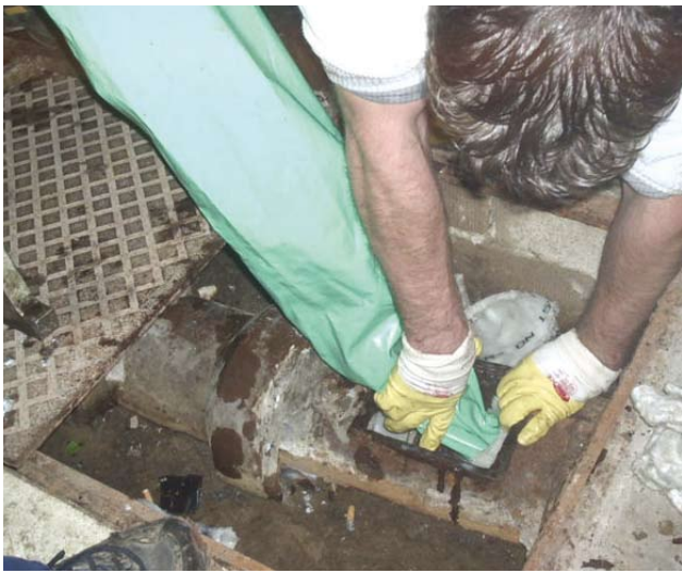
Abb. 71: Schlauchlinersanierung über einen Revisionschacht innerhalb eines Hauses: Einbringen des Stützschlauches (links), Stützschlauch an Inversionskanne angeschlossen (rechts)
