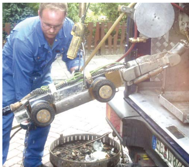
Abb. 73: Auffräsen eines seitlichen Zulaufes (links); Einsetzen des Fräsroboters über die Schachtöffnung (rechts)
