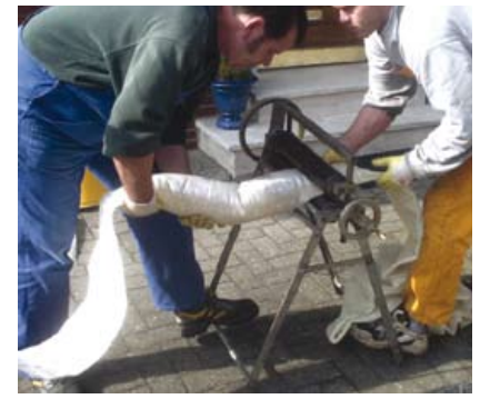
Abb. 69: Vorbereitung eines Schlauchliners; Mischung des Harzes (links), Herstellung des Vakuums in einem Gewebeschauch (Mitte), Verteilung des Harzes und Tränkung des Gewebeschauches mittels Kalibrierwalze (rechts)
