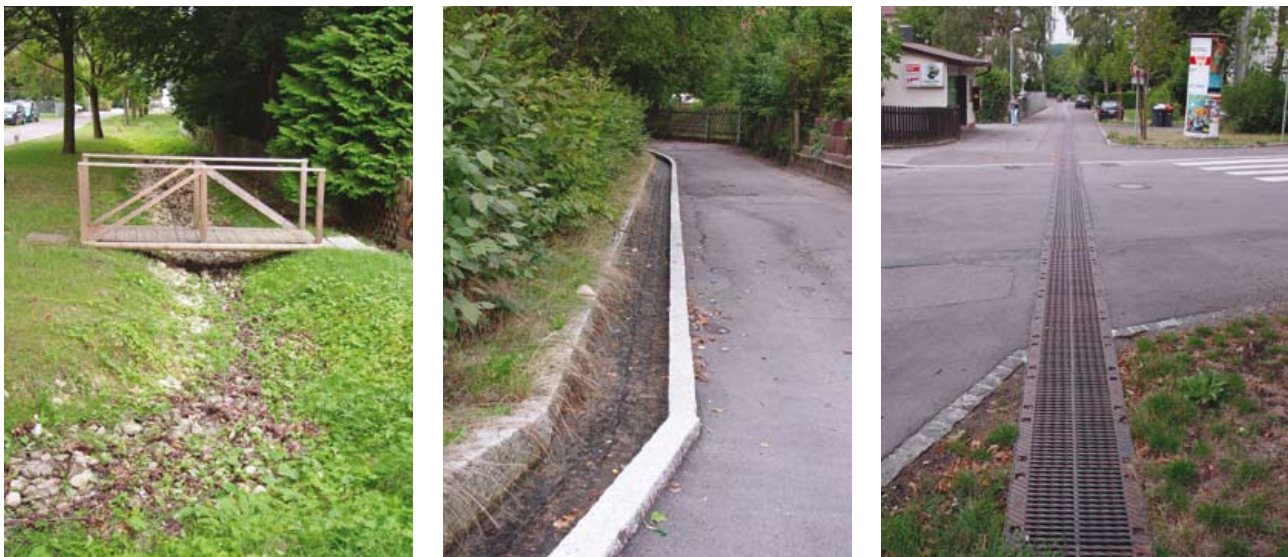
Abb. 80: Verschiedene Formen der oberirdischen Ableitung
