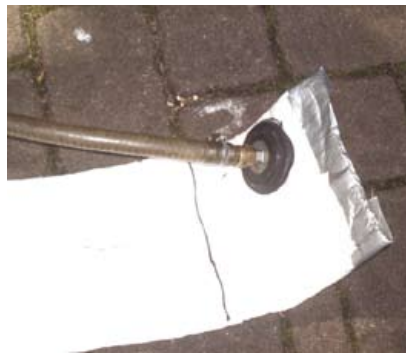
Abb. 69: Vorbereitung eines Schlauchliners; Mischung des Harzes (links), Herstellung des Vakuums in einem Gewebeschauch (Mitte), Verteilung des Harzes und Tränkung des Gewebeschauches mittels Kalibrierwalze (rechts)
