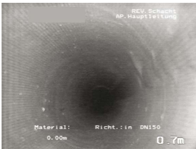
Abb. 74: Mit Schlauchliner sanierter Hauptleitungsstrang
