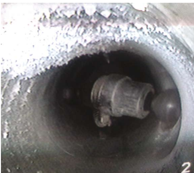
Abb. 73: Auffräsen eines seitlichen Zulaufes (links); Einsetzen des Fräsroboters über die Schachtöffnung (rechts)
