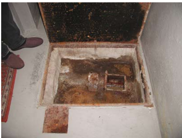
Abb. 51: Aufnahme der Entwässerungssituation vor Ort; gute Zugänglichkeit über einen Revisionschacht (links), neu erstellter und versiegelter Revisionschacht (rechts)
