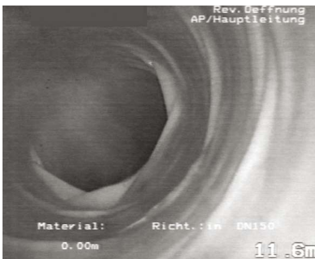
Abb. 76: Faltenbildung im Bogenbereich
