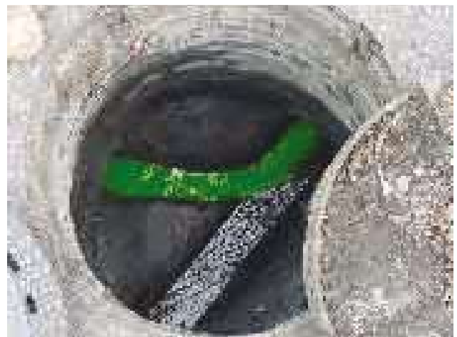
Abb. 57: Einsatz von Tracern zur Zuordnung von Einleitungsstellen in privaten Entwässerungsnetzen
