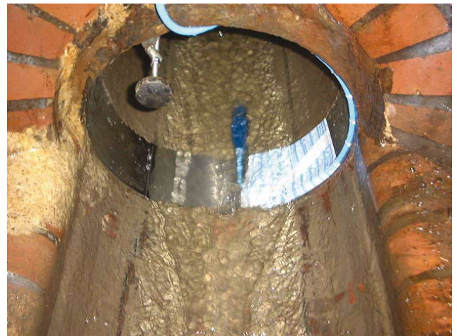
Abb. 15: Kombierter Messwertaufnehmer nach dem Ultraschall-Doppler-Prinzip
