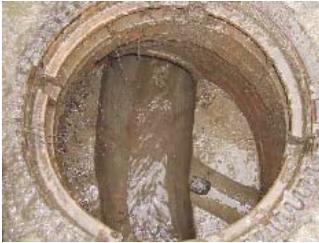
Abb. 14: Klarer Abfluss - Ein mögliches Indiz für Fremdwasser
