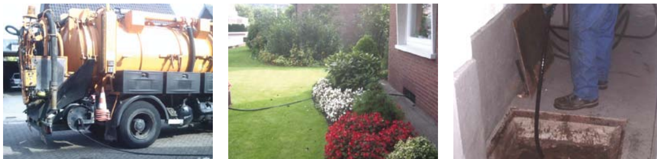
Abb. 65: Reinigung der Abwasserleitungen über den Revisionschacht innerhalb eines Hauses
