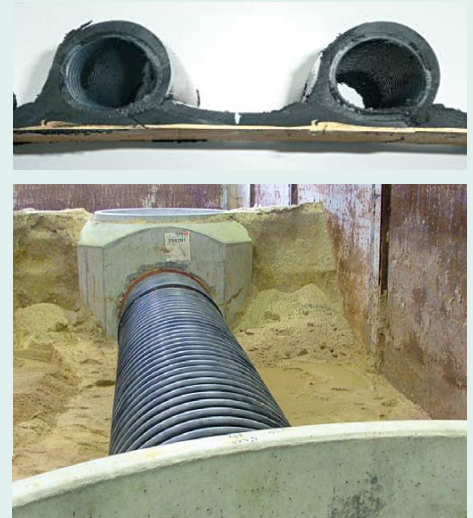
Bild 3 Aufbau der Rohrwand, Einbau der profilierten Polyethylen-Rohre
