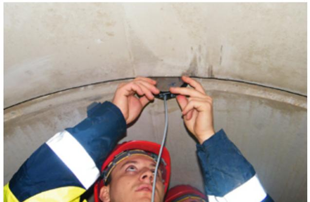
Online-Überwachung der Fugenspaltbreite während des Rohrvortriebs
