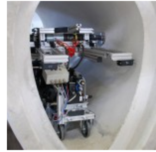
MAC-System: Verformungsmessun- gen zur Einschätzung der Standsicherheit
