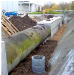
Geophysikalische Messverfahren: Aufbau der Versuchsstrecke
