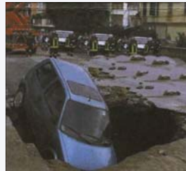
Risiko: Hohlräume im Erdreich
