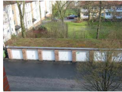
Extensiv begrünte Garagendächer Retention und Verdunstung
