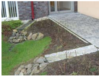
Abgeschlagene Fallrohre
