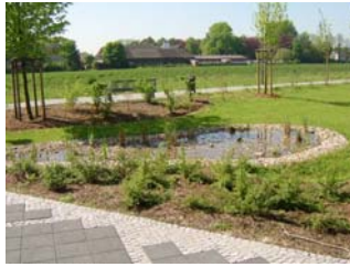
Versickerung über Mulden
