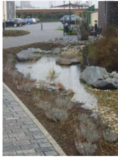
Versickerung über Mulden
