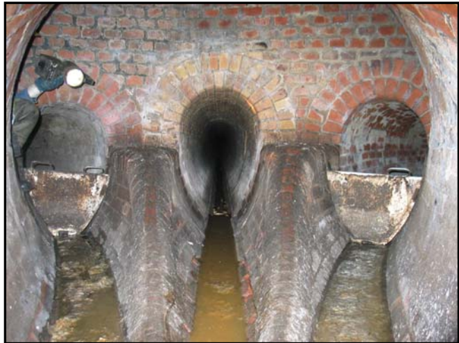
Abb. 3: Verzweigung mit eingesetzten Stauplatten
