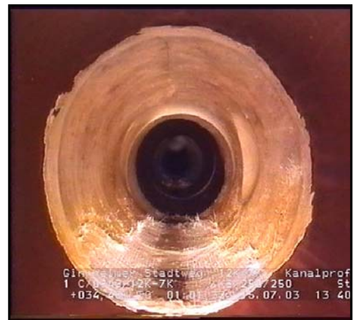
Abb. 10: Kurzliner unter Betriebsbedingungen nach zweimaliger Reinigung
