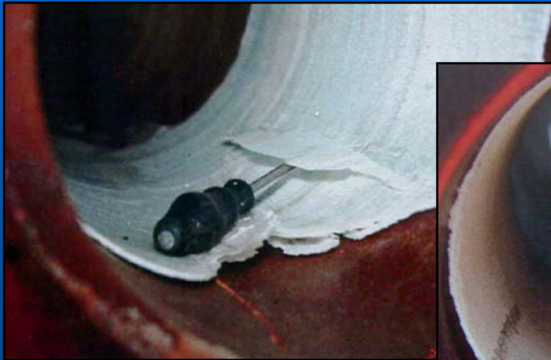
Reinigung mit Split (Prüfbedingungen)
