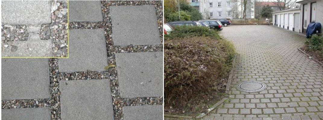
**Abb. 5:** Beispiel eines Sickerfugensteins mit angeformten Abstandshaltern
