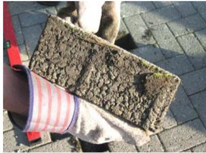
**Abb. 54:** z.T. verschmutzte Fugenfläche
