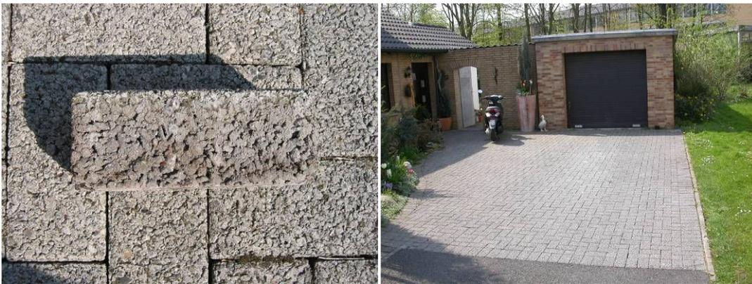
**Abb. 3:** Beispiel eines einschichtigen Filtersteins
