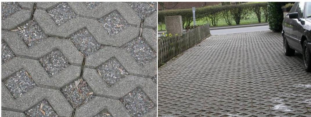
**Abb. 6:** Anwendungsbeispiel Rasengittersteine mit Splittfüllung
