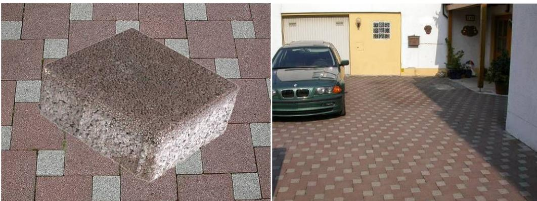
**Abb. 4:** Beispiel eines zweischichtigen Filtersteins
