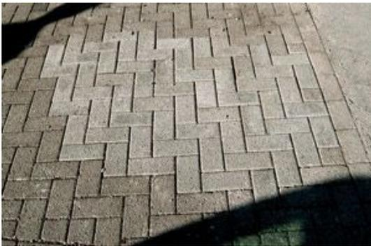
**Abb. 56:** Unterschiedliche Färbung des alten und neuen Pflasters
