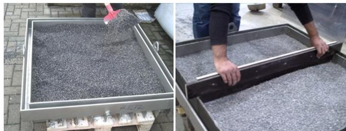
**Abb. 42:** Einfüllen und Abziehen des Bettungssplitts
