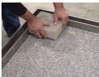
**Abb. 43:** Setzen der Steine
