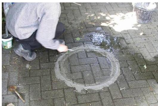
**Abb. 30:** Entfernung des Blitzzementes
