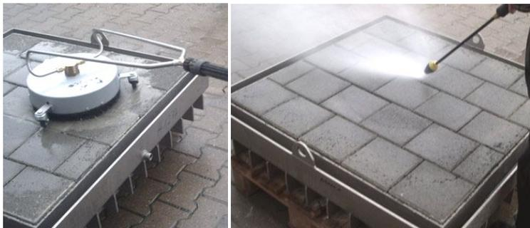
**Abb. 48:** Reinigung des Belages mittels Bürstenaufsatz und Wasserhochdruck
