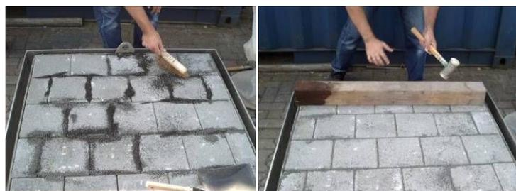
**Abb. 44:** Einfegen und Verdichten des Fugensplitts
