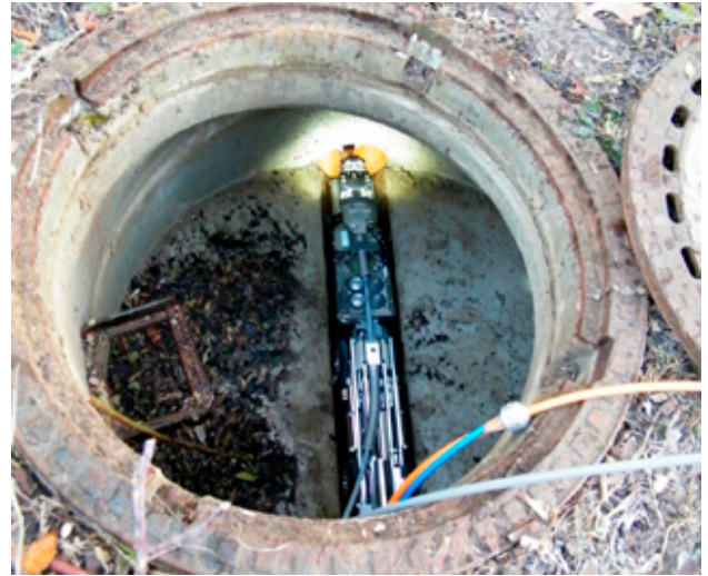
Kamerainspektion auf dem Grundstück
