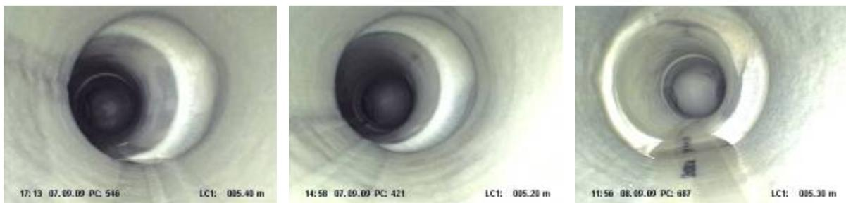
lineTEC ProFlex Liner, Harzsystem: Biresin lineTEC EP 40, VFG Vereinigte Filzfabriken AG, Giengen
