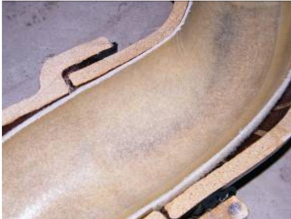
Steinzeug-Bogen 45°, DN 125, Sohlbereich vertikal angeordnet
