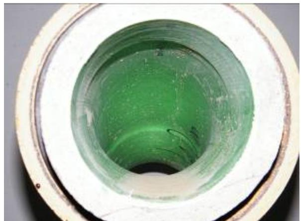
Steinzeug-Bogen 30°, DN 150, vertikal angeordnet, in Fließrichtung
