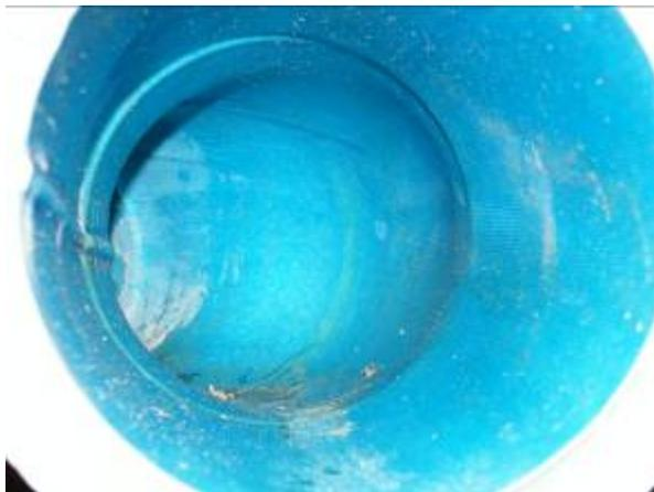
Steinzeug-Bogen 45°, DN 150, horizontal angeordnet, in Fließrichtung
