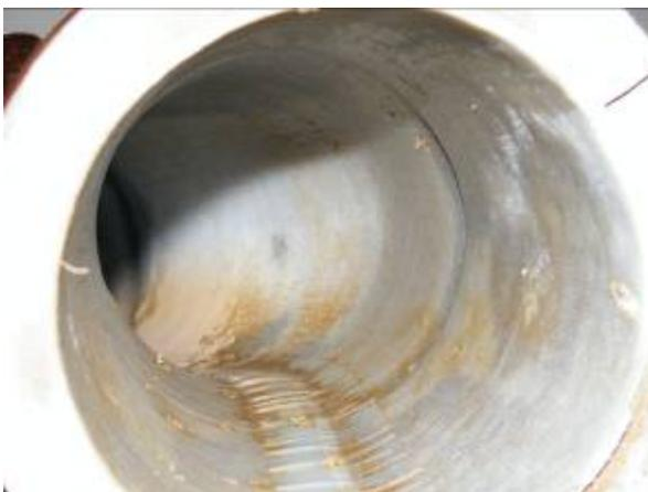
Steinzeug-Bogen 45°, DN 150, horizontal angeordnet, gegen Fließrichtung
