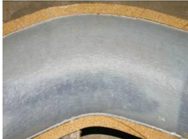
Steinzeug-Bogen 45°, DN 125, Sohlbereich vertikal angeordnet
