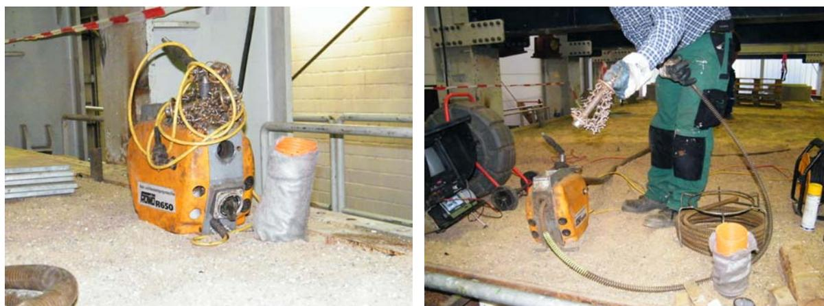
Abbildung 49: Einsatz der Kettenschleuder
