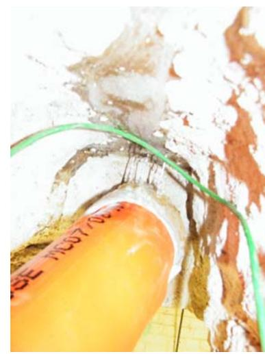
f) Invertierter Kalibrierschlauch am Leitungszugang
