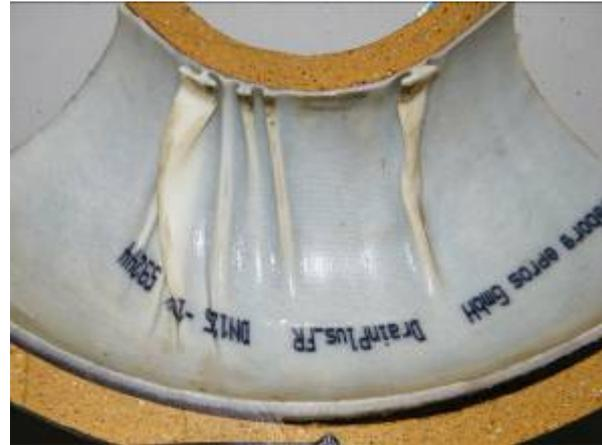
Steinzeug-Bogen 90°, DN 125, vertikal angeordnet
