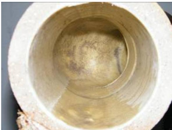
Steinzeug-Bogen 30°, DN 150, horizontal angeordnet, in Fließrichtung
