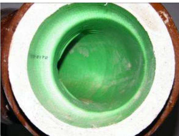
Steinzeug-Bogen 45°, DN 125, Nennweiten wechsel DN 125 auf DN 150, gegen Fließrichtung
