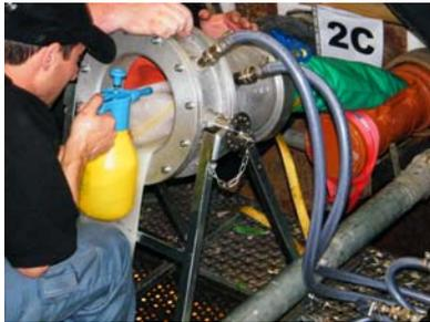
j) und k) Inversion des Liners mit einer „Linerung“
