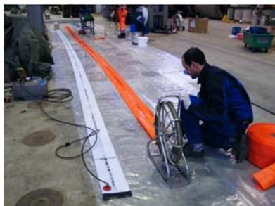
d) Ablängen des Liners und des Kalibrierschlauches
