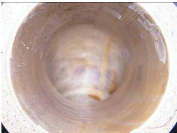
Steinzeug-Bogen 45°, DN 150, vertikal angeordnet, in Fließrichtung
