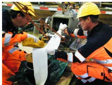
l) Einziehen des mit Gleitmittel benetzten Schlauches in die Inversionstrommel
