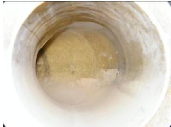
Steinzeug-Bogen 45°, DN 150, horizontal angeordnet, gegen Fließrichtung
