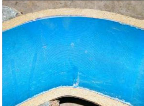
Steinzeug-Bogen 45°, DN 125, Sohlbereich vertikal angeordnet
