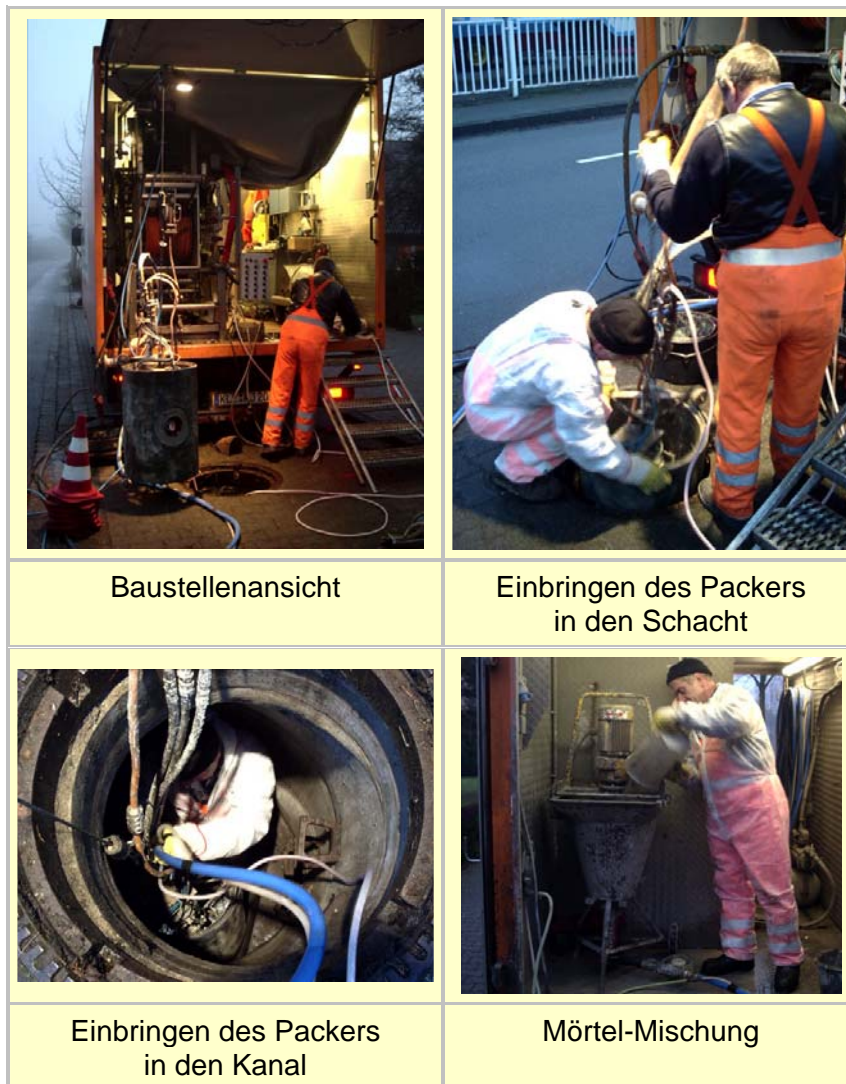
Abb.6: Eindrücke von der Baustelle
