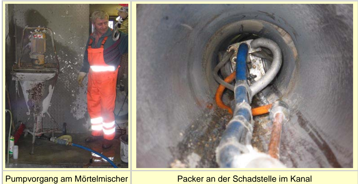
Abb. 2: Mörtelinjektion
