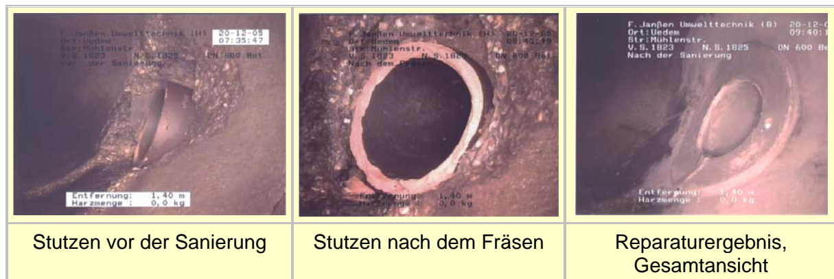
Abb.7: In situ: Reparatur und Ergebnis
