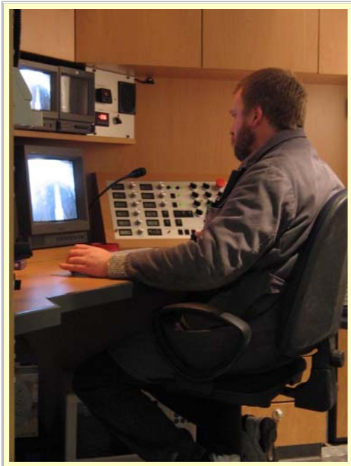
Abb. 3: Überwachung der Sanierung durch den Techniker im Sanierungsfahrzeug
