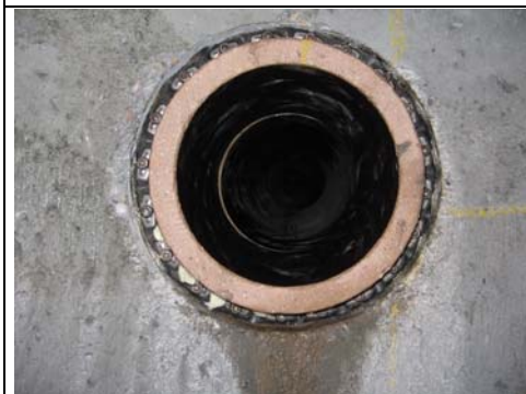
Abb. 12: Anschluss eines Kanals mit Gliederkette am Schacht
