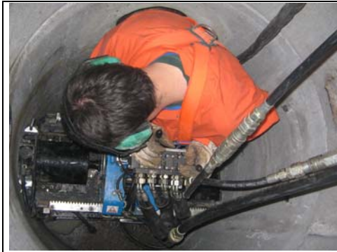
Abb. 11: Bohrung im Schacht im IKT-Großversuchsstand
