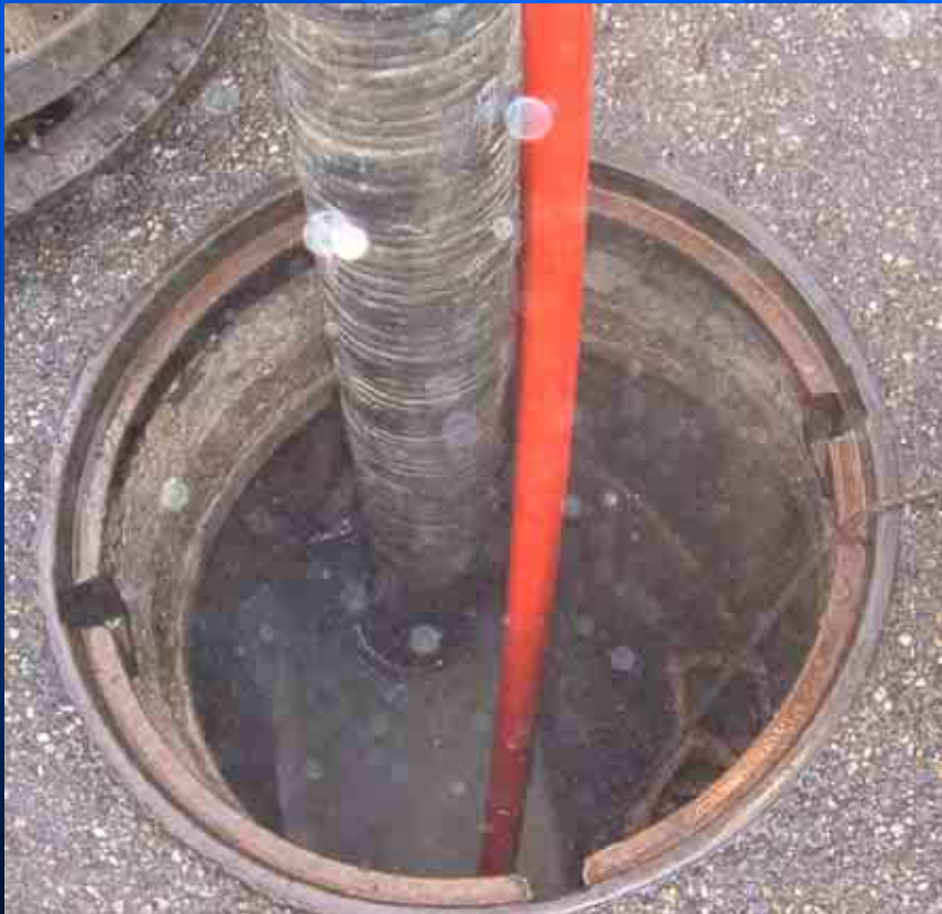
Spülen und Absaugen des Kanalräumgutes gleichzeitig!
