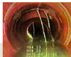
Defekte Hausanschluss leitung
