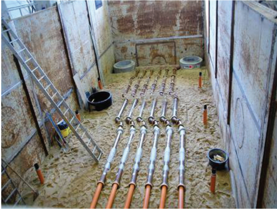
Abbildung 3: Tiefste Rohrlage vor der Überschüttung, Überschüttungshöhe 5 m
