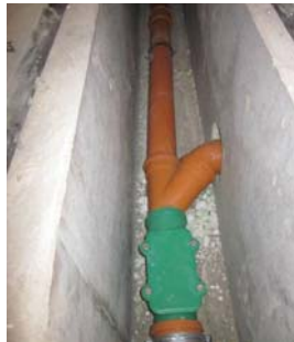
Verlegung in abgedeckter Rinne
