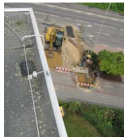
Neubau in offener Bauweise – öffentlicher Bereich
