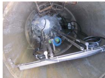
Neuer Schmutzwasserschacht mit Pumpe
