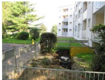
Neubau in offener Bauweise – privater Bereich
