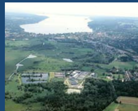
Luftbild des Verbandsgebietes mit der Kläranlage
