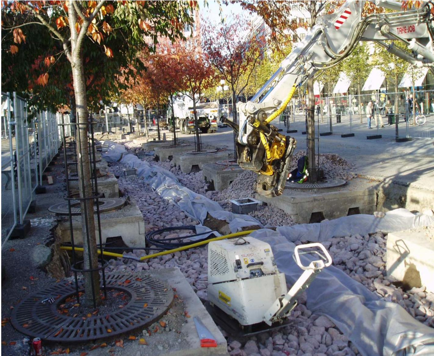
**Passive Schutzmaßnahmen** sind solche, die im direkten Bereich von unterirdischen Leitungen bzw. Leitungsgräben ergriffen werden. Der geeignete Zeitpunkt ist bei Neubau der unterirdischen Leitungen, da dann kein gesonderter Straßenaufbruch erforderlich ist. Die Wahl der Schutzmaßnahme hängt von den örtlichen Verhältnissen ab.
