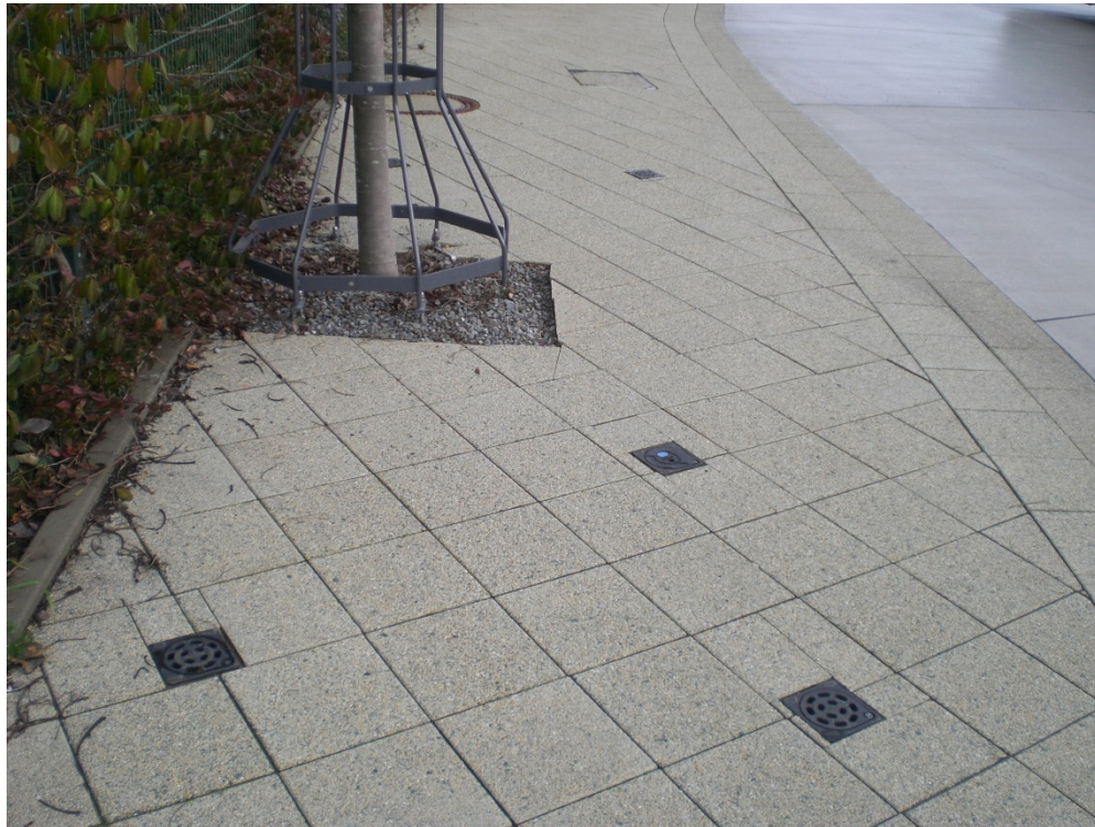
Bahnhofsvorplatz Stadt Detmold, Kurz nach der Fertigstellung.
