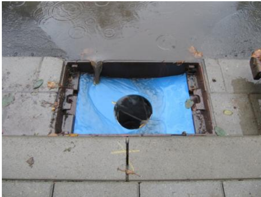
Zentrischer Wasserzulauf mittels angepasster Adapterplatte
