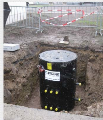
Abb. 2: Verteilerschacht Typ 1 (im Werk vorkonfektioniert zur einfachen Installation auf der Baustelle)
