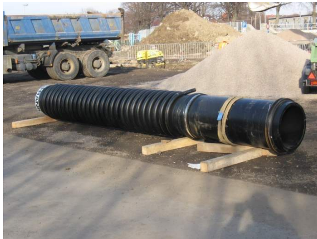
Thermopipe DN 500 mit Passtück
