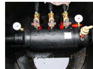
Innenansicht Verteilerschacht
