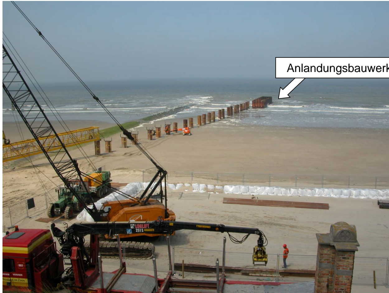
Anlandung Kabel Offshore-Windpark
