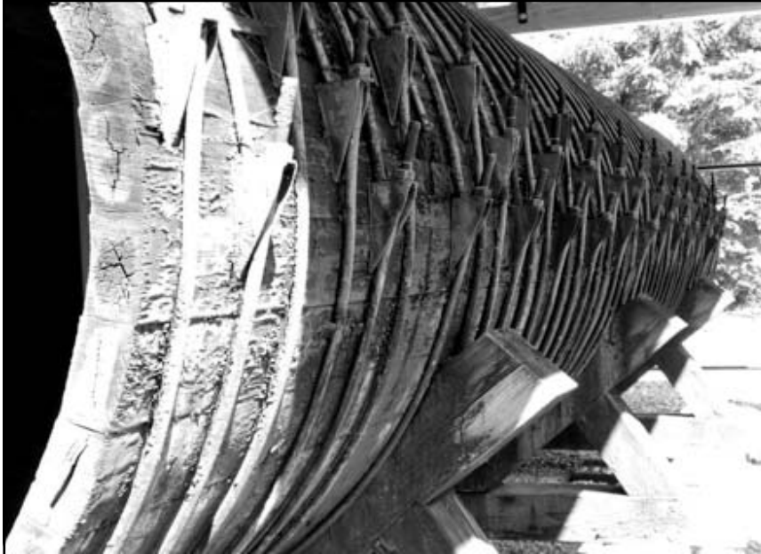
Holzdaubenrohr, Seattle, USA Von 1930 bis 1991 im Einsatz
