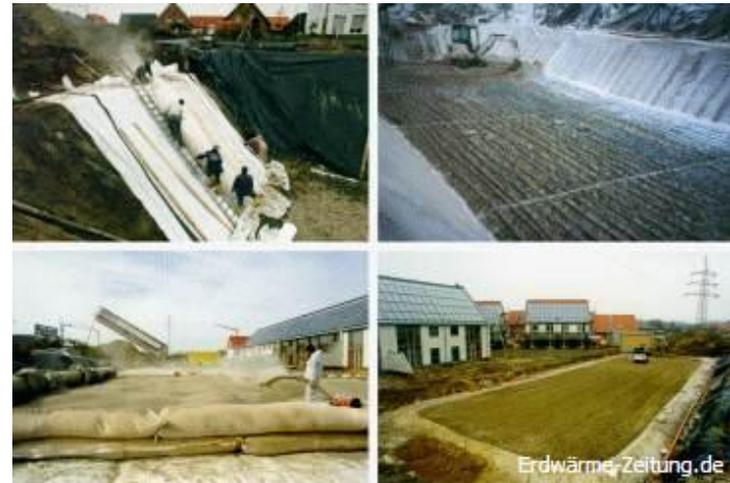
Erdbecken-Wärmespeicher 60 – 80 kW/m<sup>3</sup>
