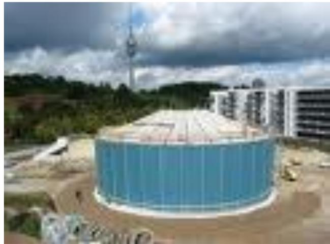
Behälter-Wärmespeicher 60 – 80 kW/m<sup>3</sup>
