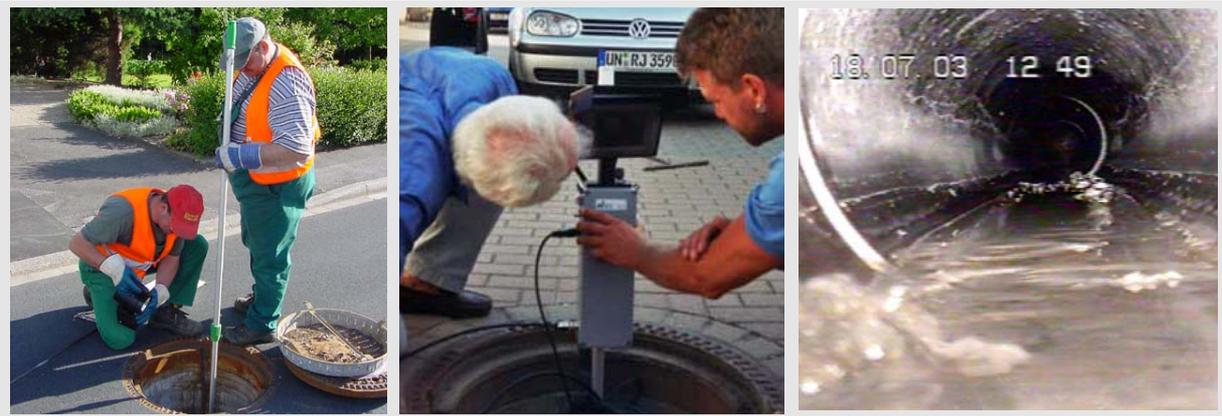
Bild 4: Ablagerungsbewertung: Im Schacht (links); in den angeschlossenen Zu- und Ablaufhaltungen durch Einsatz einer Zoom-Schachtkamera (mitte, rechts)
