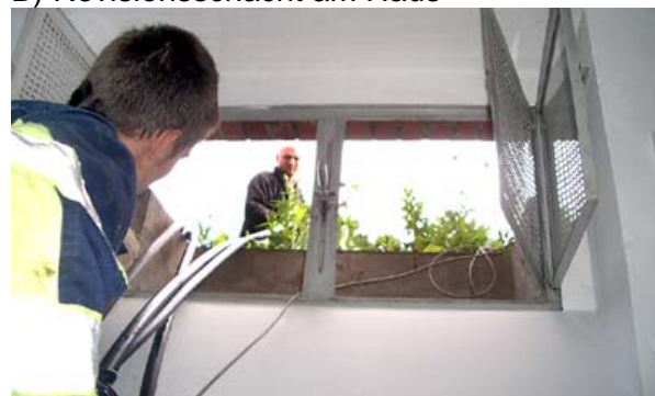
C) Zugang zum Revisionschacht im Keller
