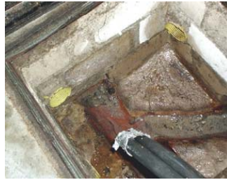
B) feuchte Dränagen am Schacht
