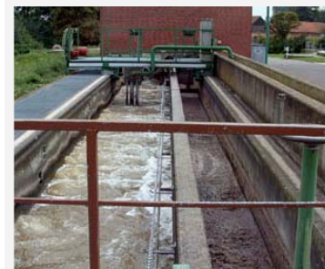
Bild 7: Belüfterter Sandfang
