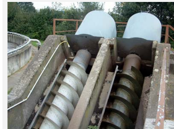
Bild 6: Abwasserhebwerk
