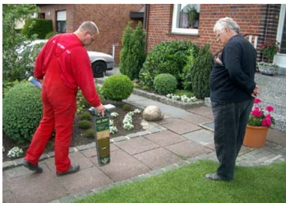
Bild 26: Ortung eines überdeckten Revisionsschachtes im Gehweg
