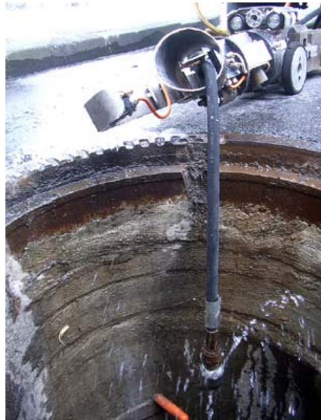
Bild 23: Inspektionsfahrzeug (o.) mit ZK Göttinger Kanalwurm im Spüleinsatz (u.) Bild 24: ORION L, Kieler Stäbchen, Beispiel mit Spüldüse zur Vorreinigung
