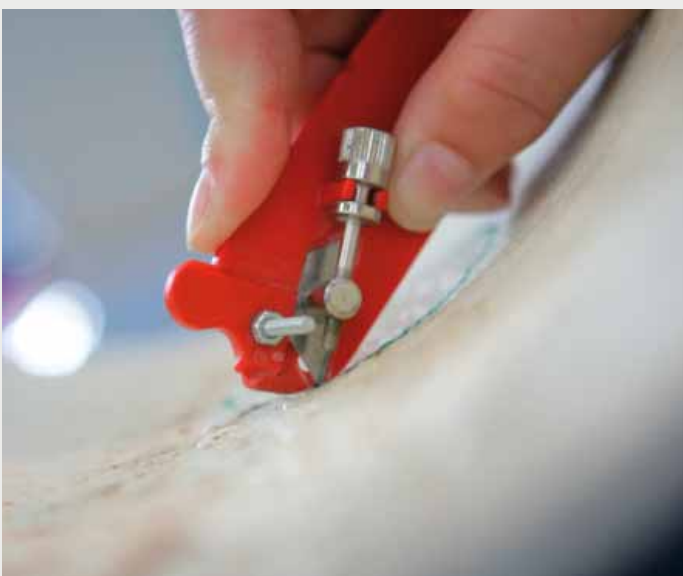
Bild 2: Einschneiden der Innenfolie mit Schnitt-Tiefenbegrenzung
