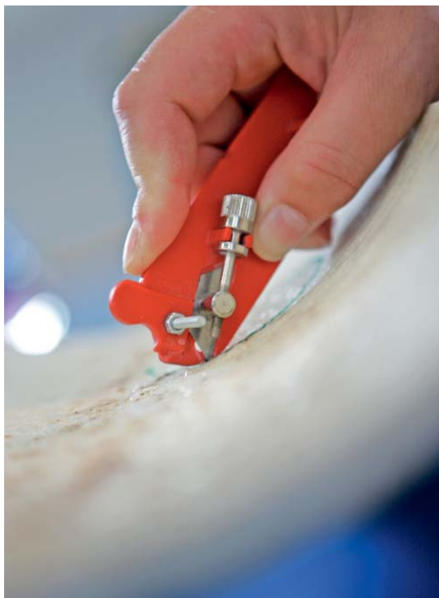
Fot. 2. Nacinanie wewnętrznej folii rękawa z ograniczeniem głębokości nacięcia
