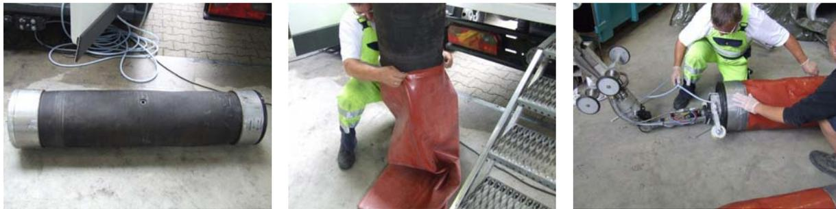
Abb. 21: Verpresspacker für DN 600 (links); Aufbringen des Silikon Schlauches auf den Verpresspacker (mittig); Ankoppeln des Verpresspackers an die Selbstfahreinheit (rechts)
