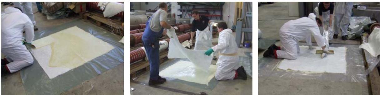
Abb. 44: Auftragen des Harzes auf das Glasfasergewebe (links), Einlegen der Polyestervlies-Kombimatte (mittig), Auftragen des Harzes auf die Polyestervlies-Kombimatte ( rechts)
