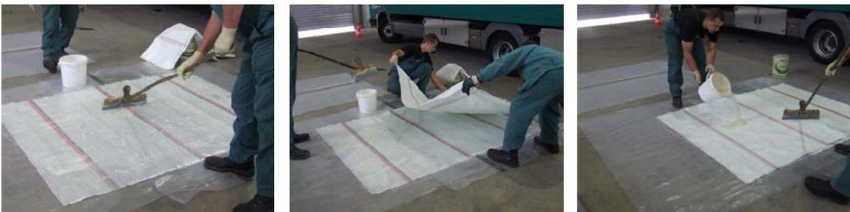
Abb. 36: Auftragen des Harzes auf das Glasfasergewebe (links), Auflegen einer weiteren Gewebelage (mittig), Auftragen des Harzes auf die zweite Gewebelage (rechts)
