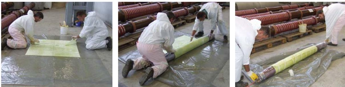
Abb. 30: Einschlagen des Glasfasergewebes zur Mitte hin (links), Aufwickeln des harzgetränkten Glasfasergewebes auf den Packer (mittig), Fixierung der Gewebematte mit Kreppband (rechts)
