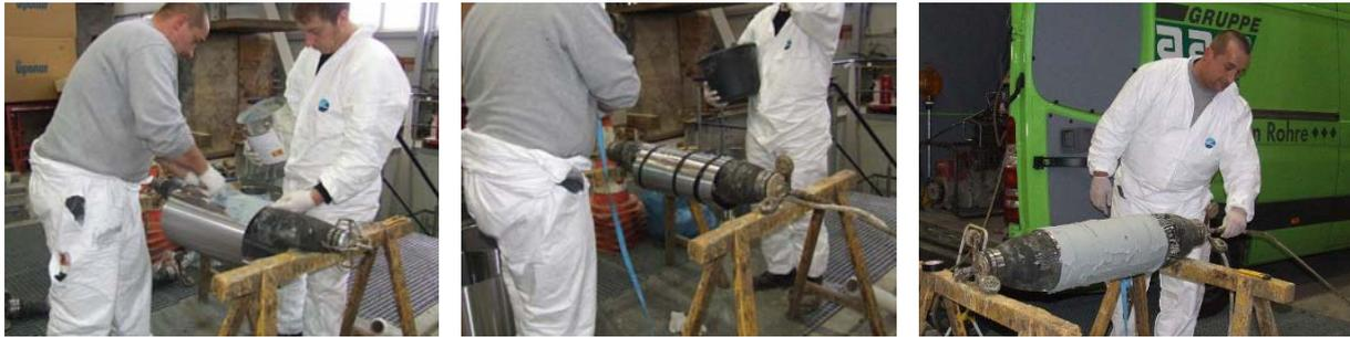
Abb. 50: Auftragen des Harzes auf die Edelstahlhülse (links), Durchmesserreduzierung der Edelstahlhülse (mittig), einbaufertige Stuttgarter Hülse (rechts)
