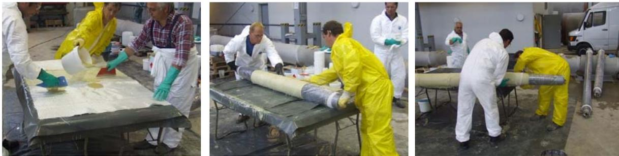
Abb. 42: Auftragen des Harzes (links), Umwickeln des Packers mit dem harzgetränktem Glasfasergewebe (mittig), Lagesicherung des harzgetränktem Glasfasergewebes mit Stülpverbänden (rechts)
