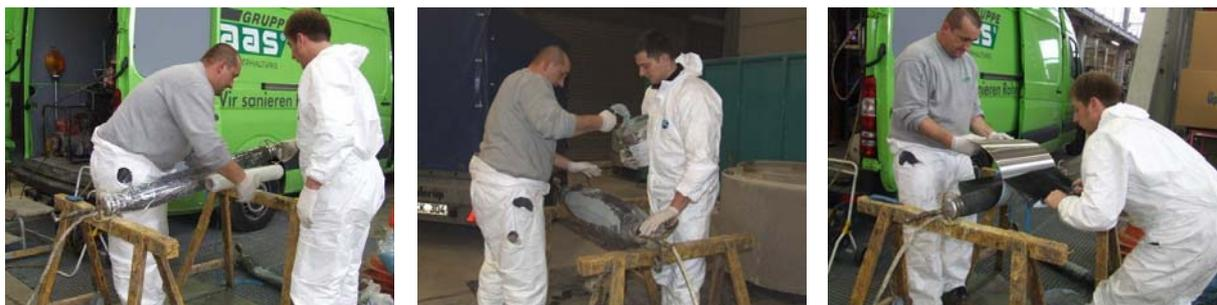
Abb. 49: Umwickeln des Packers mit Stretchfolie (links), Auftragen des Harzes zum Vorverpressen (mittig), Entfernen der Schutzfolie auf der Edelstahlhülse (rechts)
