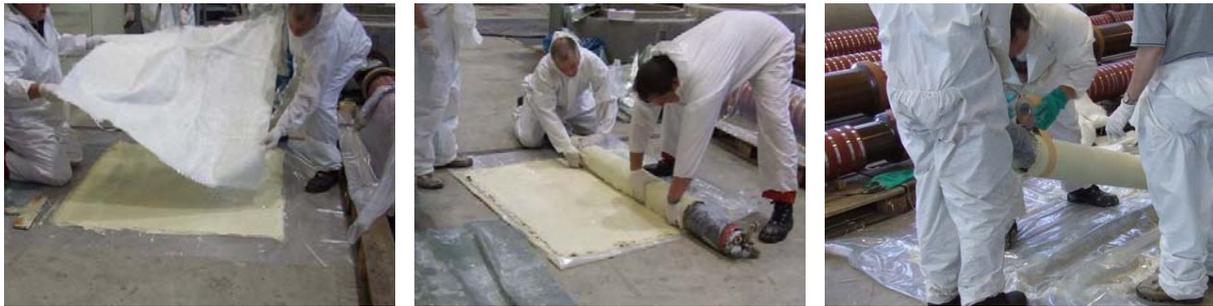
Abb. 45: Auflegen einer weiteren Lage Glasfasergewebe (links), Aufwickeln des harzgetränkten Glasfasergewebes auf den Packer (mittig), Fixierung der Gewebematte mit Kreppband (rechts)
