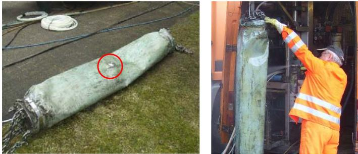
Abb. 18: Verpresspacker DN 300 (links), Auftragen des Trennmittels (rechts)
