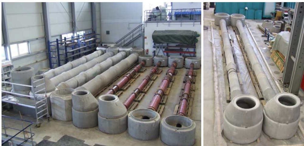
Abb. 2: Teststreckenaufbau für die Innenmanschetten und Kurzliner
