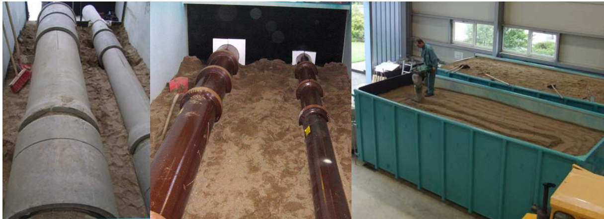
Abb. 1: Teststreckenaufbau für die Injektions- und Spachtel-/Verpressverfahren
