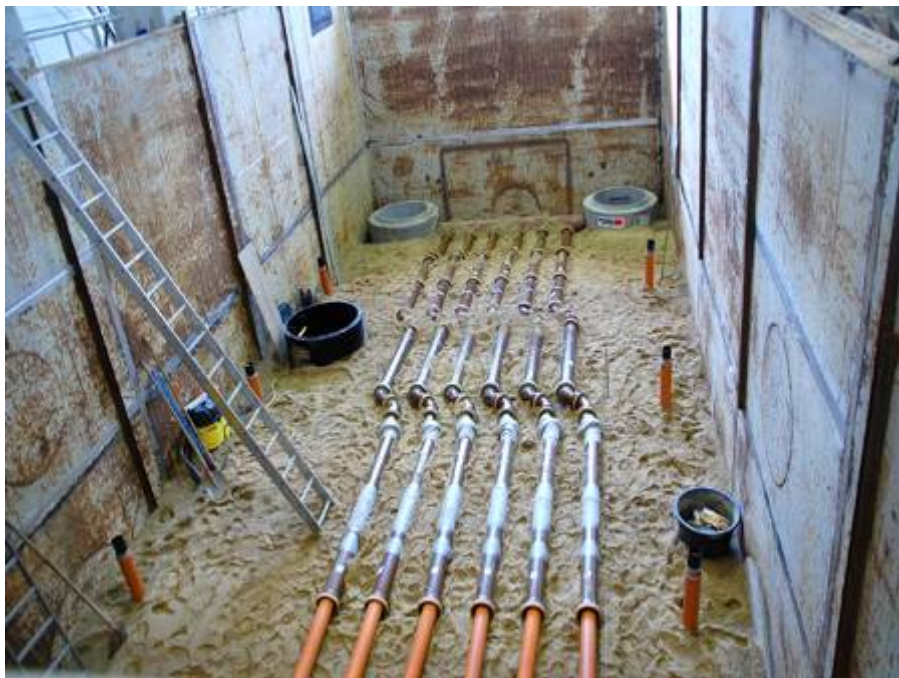
Abbildung 4: Tiefste Rohrlage vor der Überschüttung, Überschüttungshöhe 5 m
