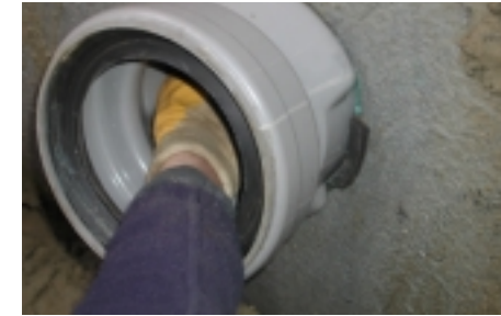
Kontrolle des Stutzens im Rohr
