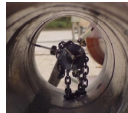
Kettenschleuder im Rohr
