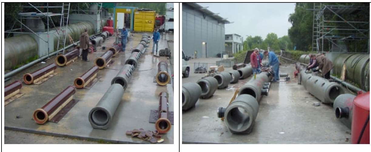
Bild 1: Einbau und Prüfungen
