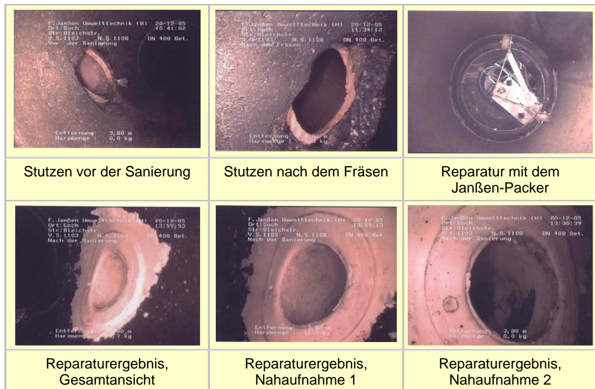
Abb.8: In situ: Reparatur und Ergebnis
