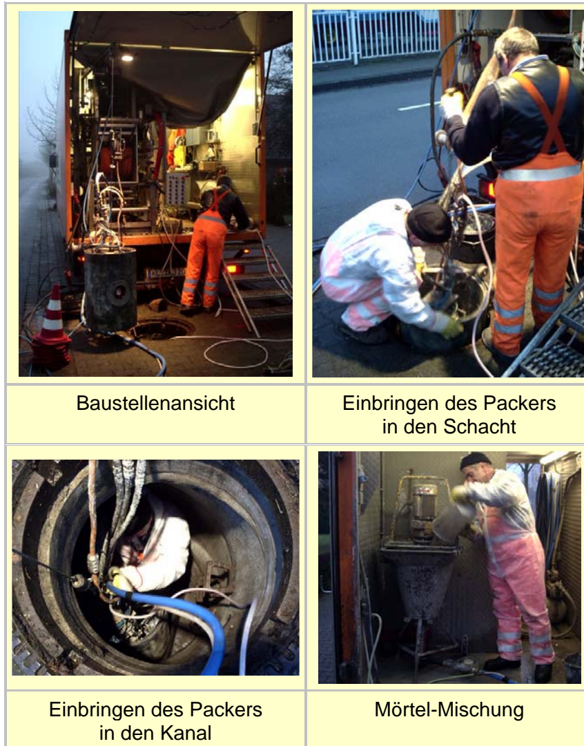
Abb.6: Eindrücke von der Baustelle
