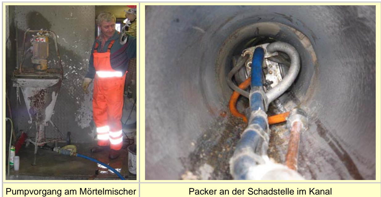
Abb. 2: Mörtelinjektion
