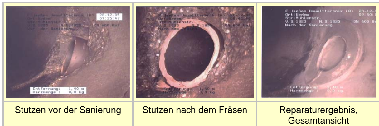
Abb.7: In situ: Reparatur und Ergebnis
