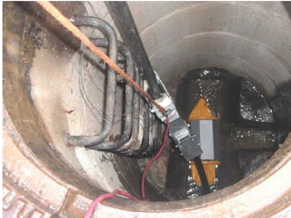
Bild 7: Einbringen der Düse in den Kanal
