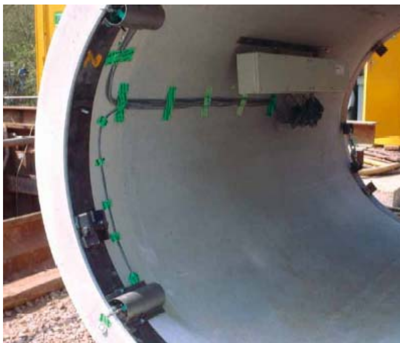
Bild 4 Vortriebsrohr mit eingebauter Messtechnik und Verkabelung [2]
