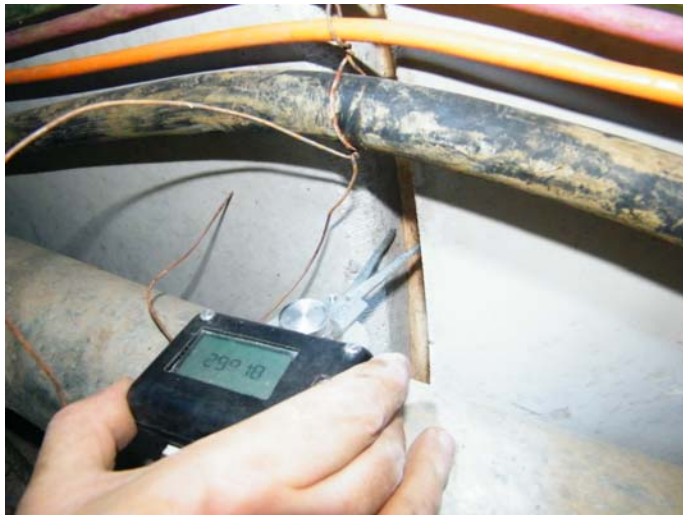
Bild 15: Fugenspaltmessung mit elektronischem Innentaster
