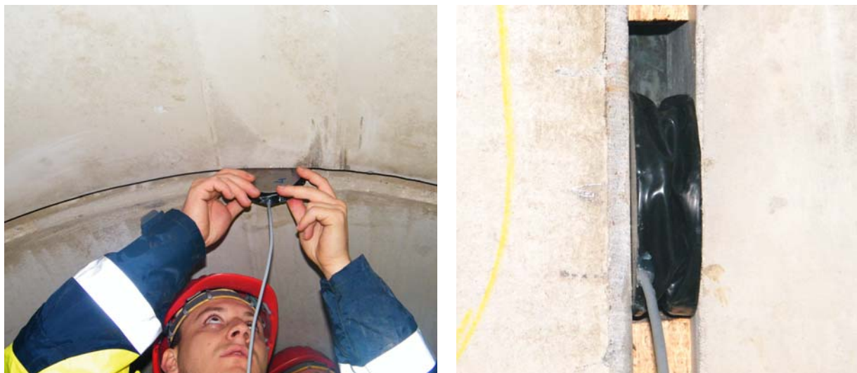
Bild 10: Einbau der kapazitiven Verformungsmessdosen
