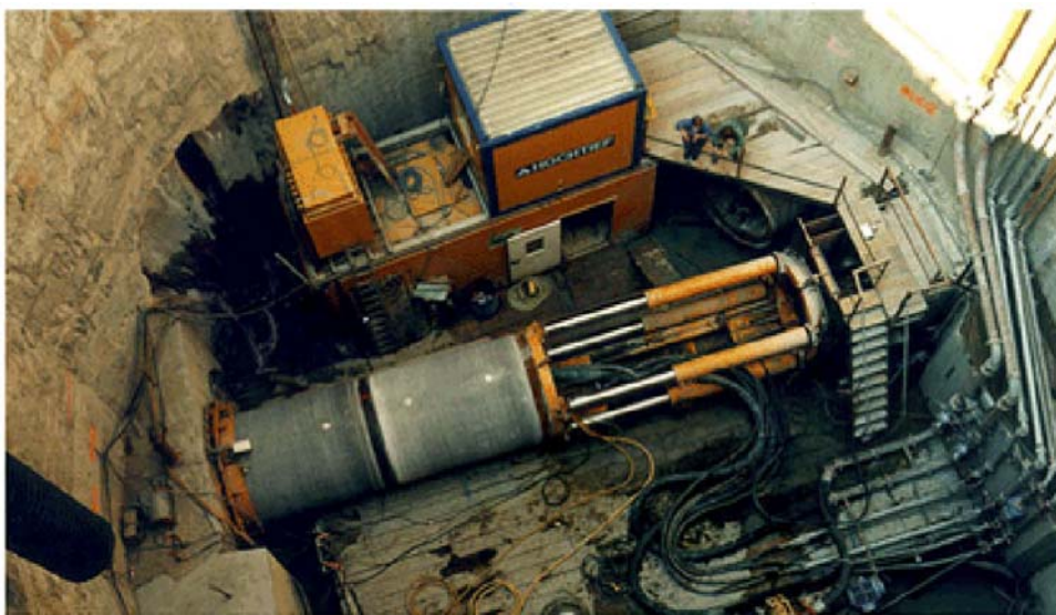
Bild 1 Startbaugrube eines Rohrvortriebs
