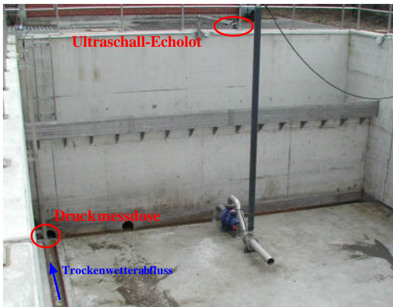
Abbildung 19: Getrennte Messwertaufnehmer zur Aufzeichnung von Füllstand (Druckmessdose) und Überfallhöhe (Echolot)
