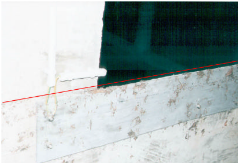
Abbildung 20: Entlastungsschwelle nach einem Beckeneinstau (rote Linie = Einstauhöhe)
