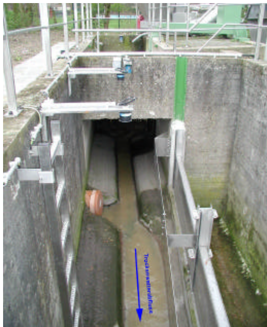
Abbildung 17: Beckenüberlauf mit zwei Messwertnehmern entlang der Entlastungsschwelle
