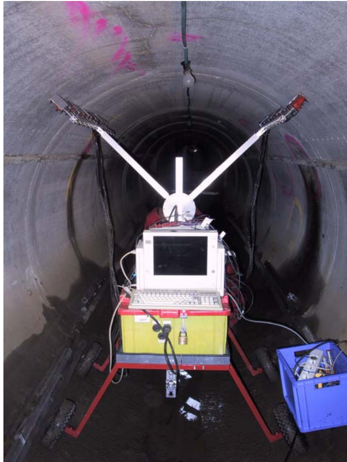
Abbildung 1: Systemträger zur Durchführung von Seismik- und Radarmessungen innerhalb eines Kanals.
