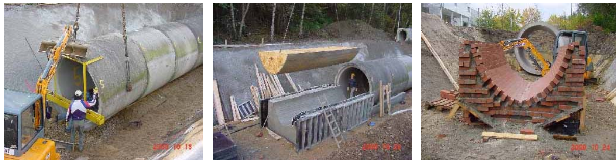
Abbildung 3: Bau der Versuchsstrecke
