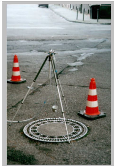
Bild 3: Messung über dem geschlossenen Einsteigschacht
