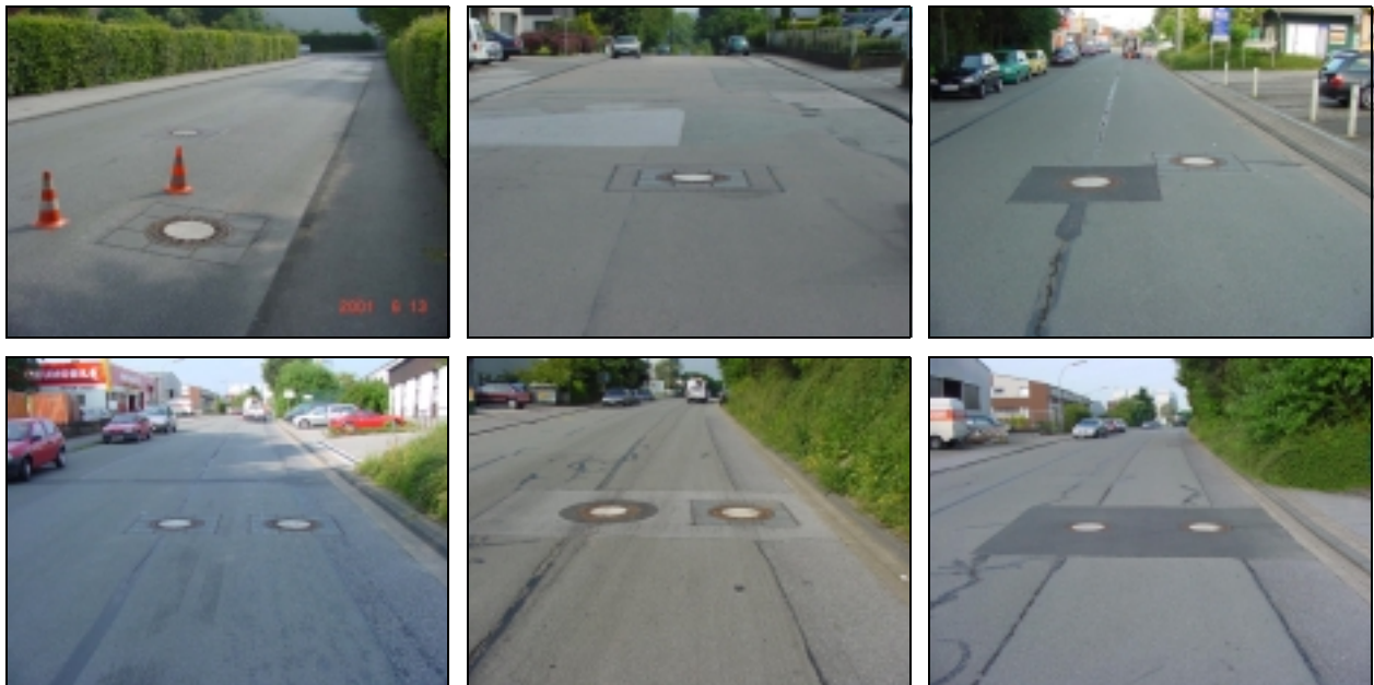
Abbildung 2: Beispiele für die im Rahmen des Forschungsvorhabens sanierten Schachtabdeckungen
