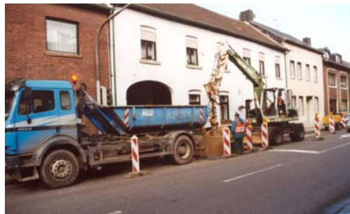
Bild 8: Baustellensituation bei offener Bauweise
