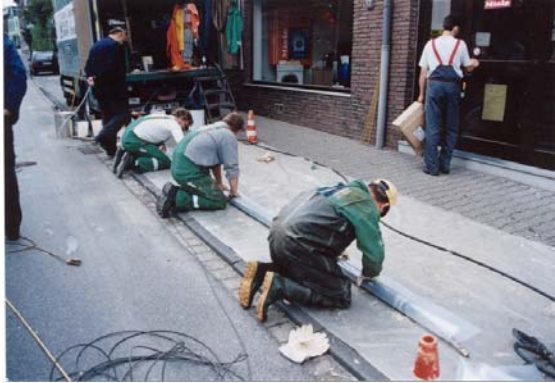
Bild 5: Mitarbeiter einer Sanierungsfirma bereiten eine Hausanschlussanierung vor (Kurzschlauchverfahren)
