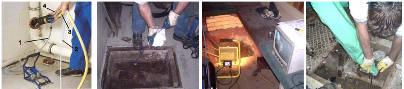
Abb. 4 -7: Wenn Revisionsöffnungen vorhanden sind, ist zumindest der Zugang leichter möglich
