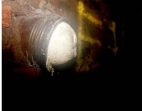
Bild 6: Neues Rohr im Altrrohr (Schlauchlining)
