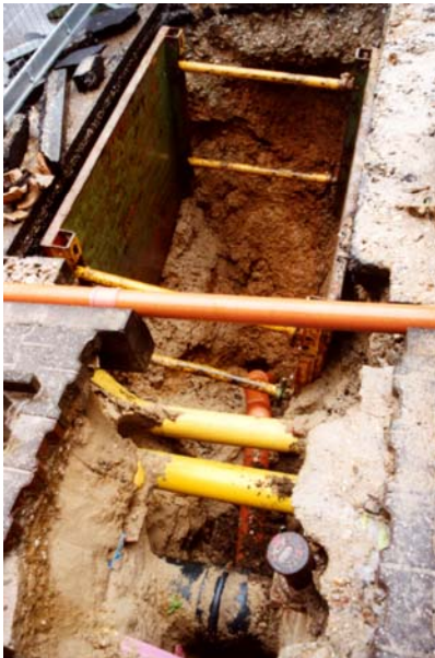
Bild 7: Problem querender Leitungen bei offener Bauweise
