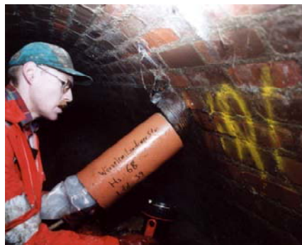
Bild 20: Vorbereitung der Materialprobe
