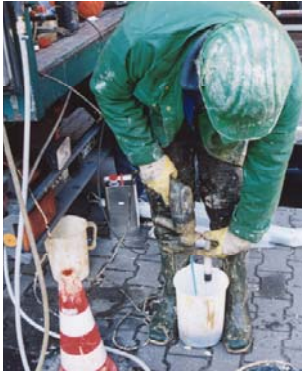
Bild 26: Manuelles Ansetzen der Harzmischung
