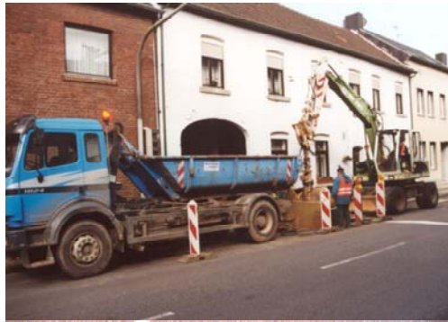
a) und b) Oberfläche aufnehmen und freischichten
