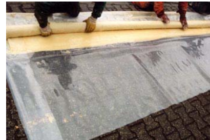
Bild 28: Vorbereitung und Einbau des Kurzschlauches
