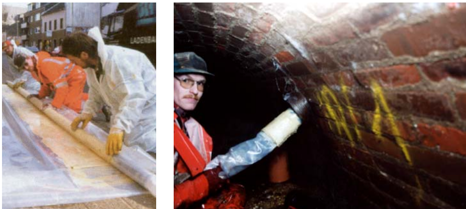
a) Vorbereitung b) eingeschobener Kurzschlauch
