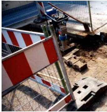
a) und b) Oberfläche aufnehmen und freischichten
