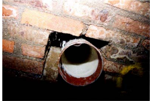
Bild 13: Einblick in Hausanschlusskanal
