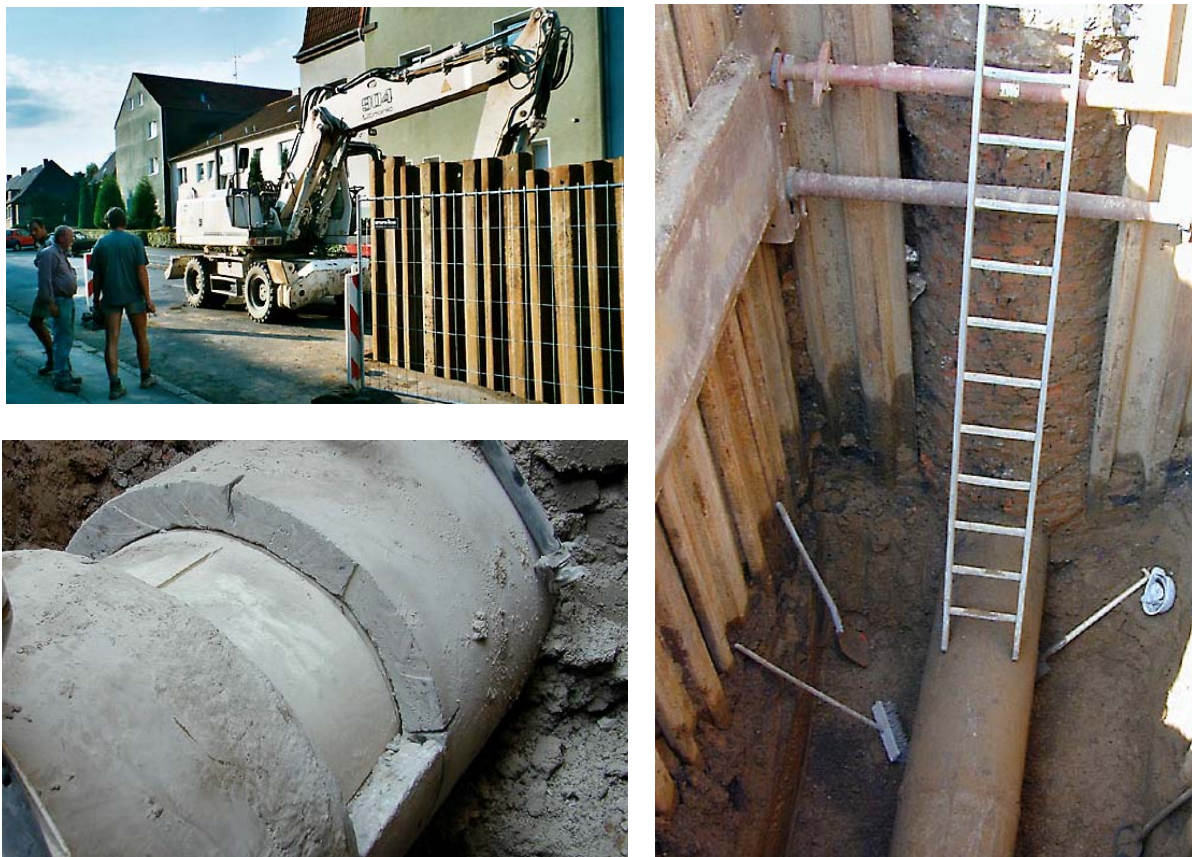
Bild 2: Entnahme von Probekörpern aus in Betrieb befindlichen Haltungen, Beispiel
