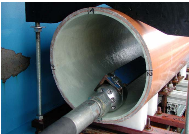
b) Prüfdüse wird in das Rohr geführt
