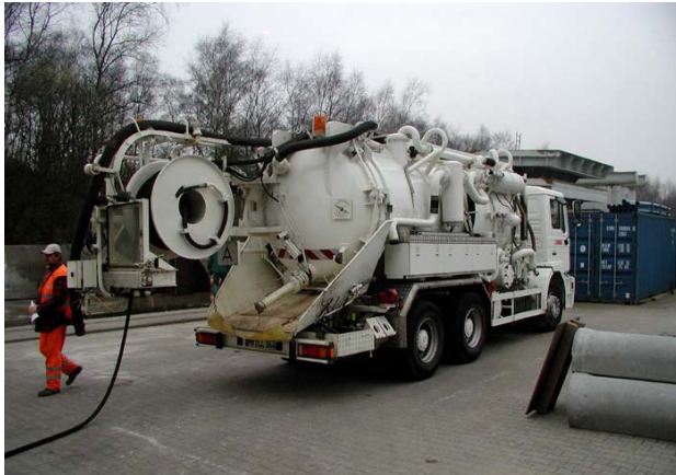
a) HD-Spülfahrzeug stellt Pumpenleistung
