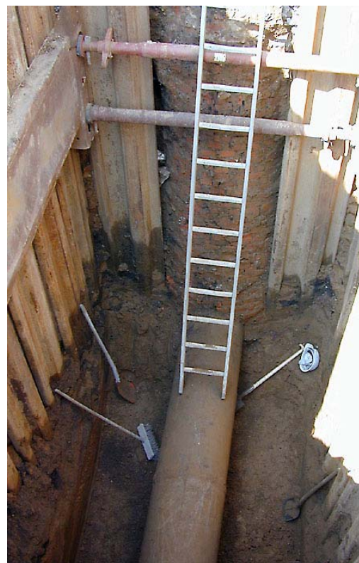
Bild 6: Entnahme von Probekörpern aus in Betrieb befindlichen Haltungen, Beispiel
