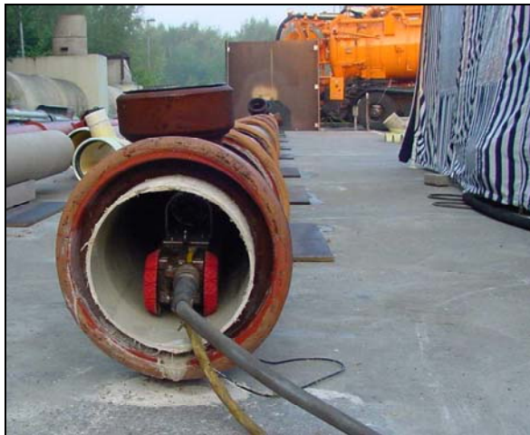
Bild 36: Zustandskontrolle mit TV-Kamera
