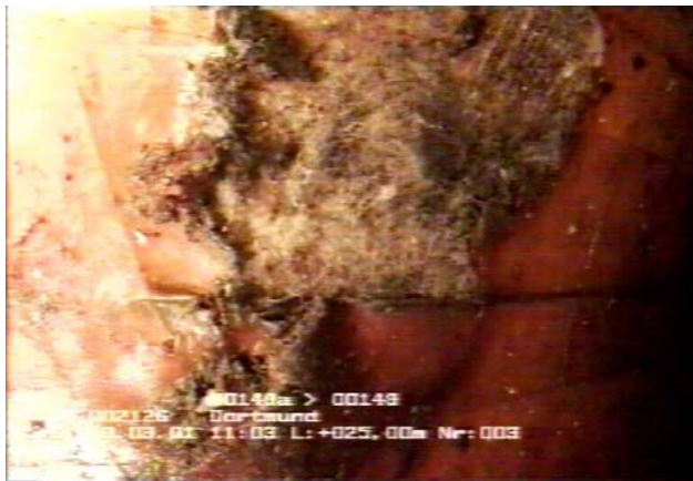
Bild 55: Freiliegende Fasern
