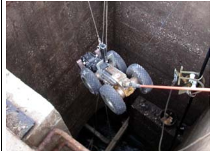
Abbildung 21: Einsetzen der Kamera
