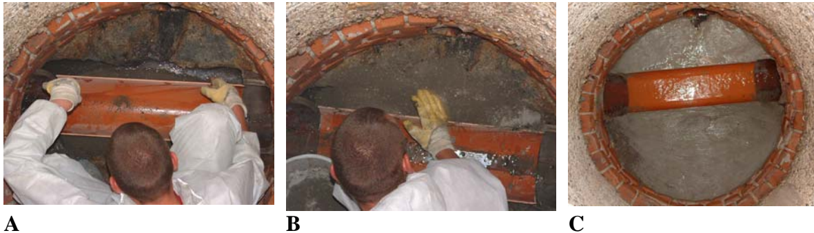
Abb. 19: Instandsetzung des Gerinnes und der Berme. A: Einsetzen einer Halbschale in das Gerinne. B: Ausbessern der Berme mit mineralischem Mörtel. C: Instandgesetztes Gerinne und Berme.
