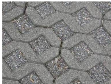
Abb. 5: Rasengittersteine mit Splittfüllung
